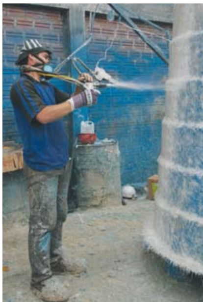
OPERARIO en pleno trabajo.
