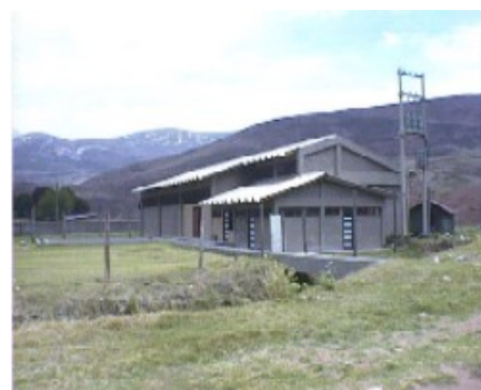
Planta de procesamiento de truchas de Pachacayo, actualmente
